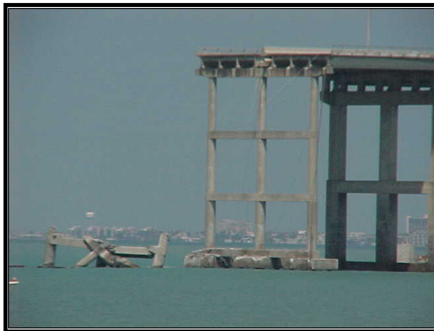
Rajah 1.7 : Runtuhan jambatan yang menghubungkan Pulau South Padre, Texas ( STBD, 2001)
