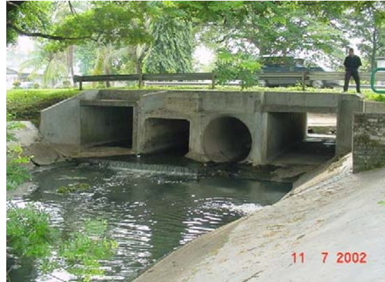
Foto 1.8 - Bentuk struktur kelubung yang berbeza dan sempit akan mengakibatkan kenaikan paras air di CH950
