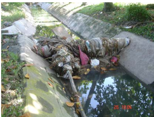
Foto 1.5 - Paip lama yang merintang struktur saluran menyekat laluan air dan memerangkap sampah mengakibatkan limpahan air di CH 3600
