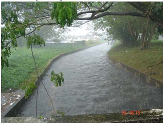
Foto 1.9 – Sistem saliran utama yang telah penuh di CH 1800 semasa hujan lebat
