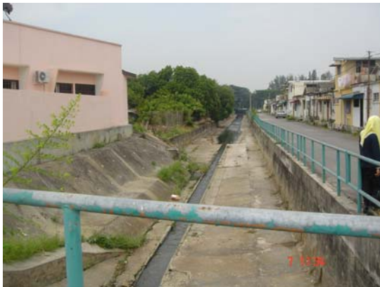
Foto 1.3 - Struktur saluran bentuk segi empat yang telah dinaik taraf pada tahun 90an di CH2900 – CH1300 ( kawasan tengah )
