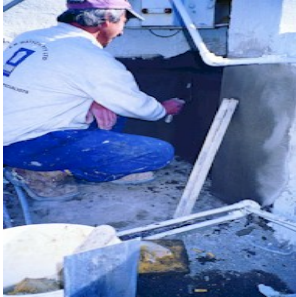
Rajah 1.7: Seorang pekerja membuat kerja baik pulih konkrit akibat serangan air laut (Sumber : http://www.psrc.usm.edu/macrog/pva.htm ).
