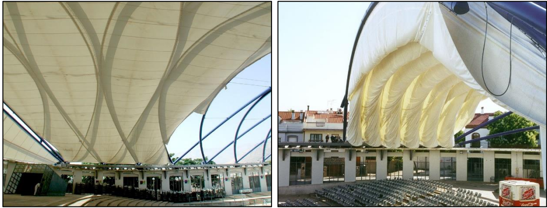
(d) Jaén Auditorium in Jaén, Spain (Escrig, 1999)
