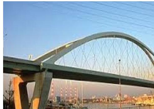
(d) Tied-arch bridge: Shinhamadera Bridge, Japan
