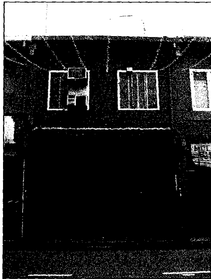
Gf 1.11 : Unit Pendingin Udara Di Tingkap Hadapan Rumah Kedai (Jalan Laksamana), 2006
