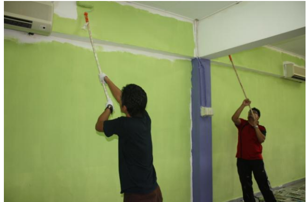
Mengecat pusat sumber
