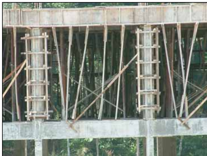
Gambarajah 1.1 : Kayu sebagai acuan dan penyokong konkrit di tapak pembinaan
